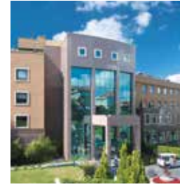
Acıbadem Dr. Şinasi Can (Kadıköy) Hospital
